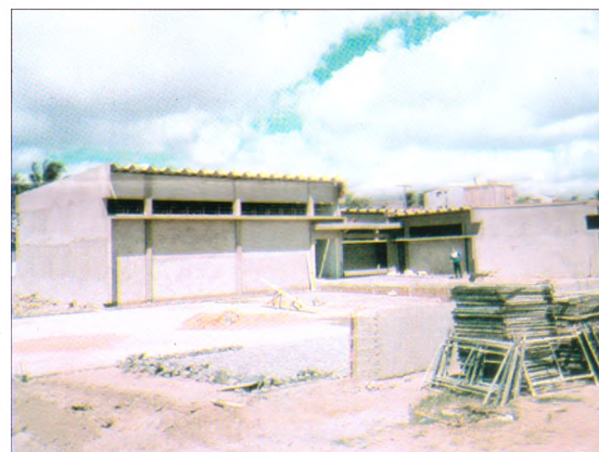
AS OBRAS já estão bastante adiantadas
